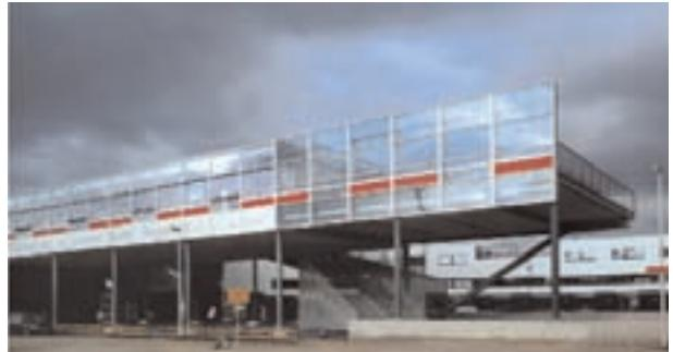
تراس رو به جنوب بزرگی نقش فضای بازی را ایفا می‌کند، هرچند می‌تواند اگر ضرورتی در آینده پیش آید، برای دیگر اهداف نیز استفاده شود. تنوع مصالح مورد استفاده در نمای خارجی اندک است: شیشه و پانل‌های فلزی برای سطوح همراه با چوب ترتیبی. پله‌های خارجی از بتن و با نرده‌های فلزی تشکیل شده‌اند، ستون‌هایی که ساختار طبقه فوقانی را تحمل می‌کنند، فلزی هستند اما با آبی، سبز و بنفش رنگ آمیزی شده‌اند.
